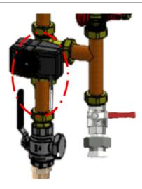
La consigne de la vanne doit être réglée à la température limite maximale en entrée de votre PAC - 5K.
